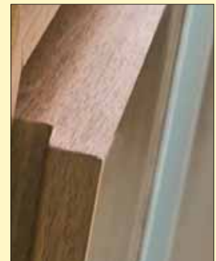
górną krawędź skrzydła w systemie bezprzylgowym
