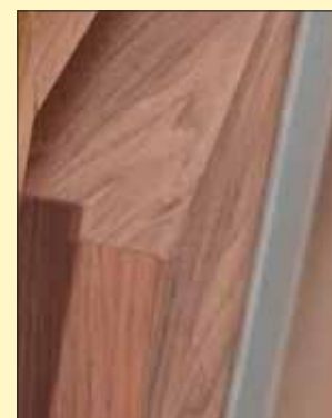
górna krawędź skrzydła w systemie bezprzylgowym
